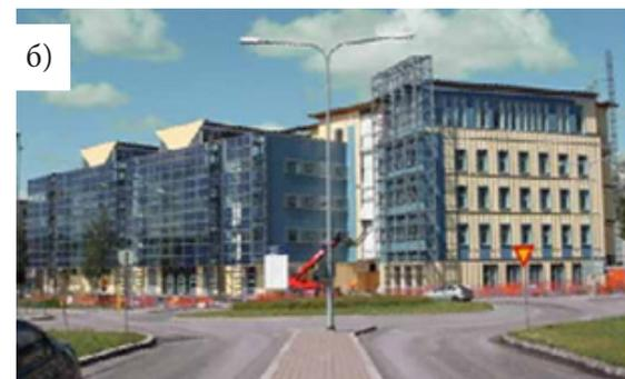
Рис. 3. Жилой комплекс Есо-Viikki: а – общий вид комплекса, б – общий вид жилых зданий, на фасадах которых расположены полупрозрачные фотоэлектрические системы
